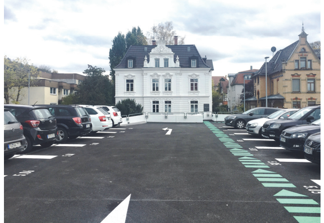
Freideck nach der Instandsetzung
