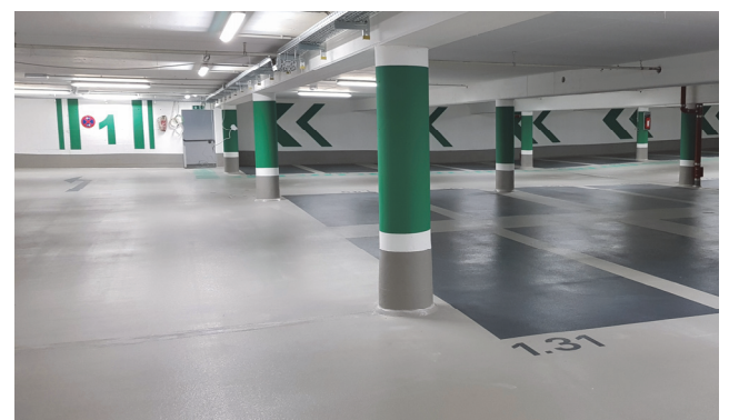
Untergeschoss nach der Instandsetzung
