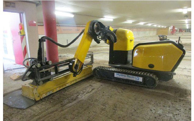
Mit Höchstdruckwasserstrahlen wird der chloridhaltige Beton abgetragen (Foto: AMP)
