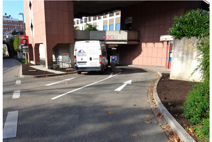
Einfahrt zur Tiefgarage (Foto: AMP)
