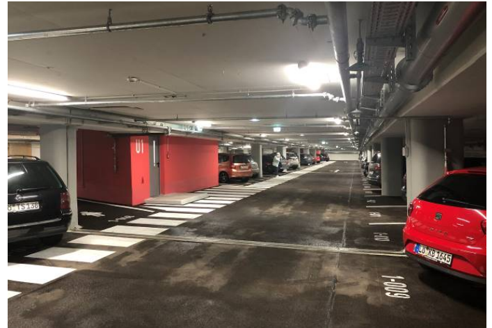
Parkgasse nach der Instandsetzung (Foto: AMP)
