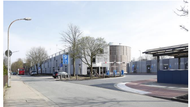
Südwestecke Auffahrtsspindel (Foto: Eva Thöle)
